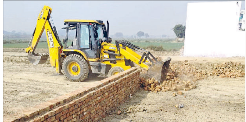
बहादुरगढ़। विकास नगर के निकट अवैध निर्माण ढहाती नप की जेसीबी।
